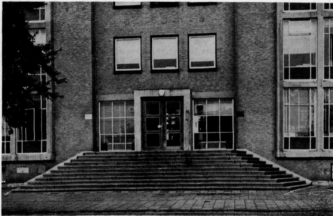
De ingang van de Luchtmacht Stafschool
