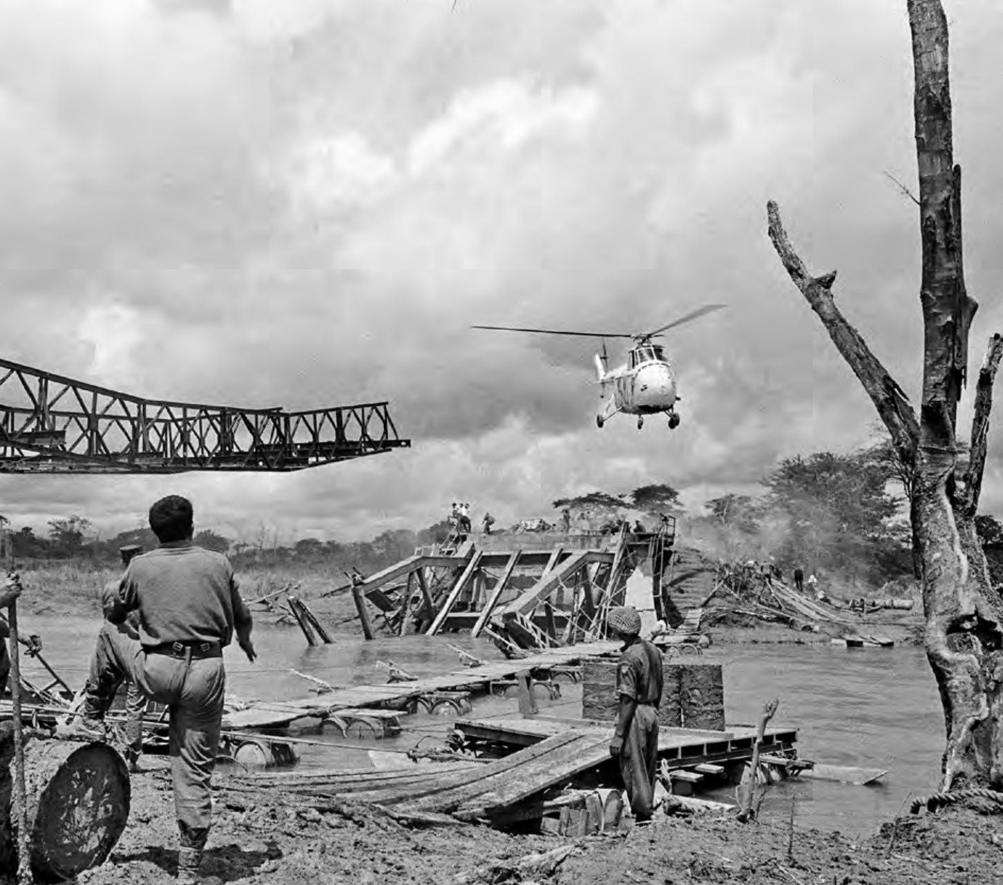
ONUC-militairen helpen bij de reparatie van een verwoeste brug over de Lufira-rivier in de provincie Katanga (januari 1963)
